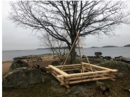
Saxemara nyrestaurerade yttre badplats efter restaurering
