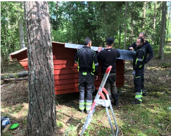
Byggnation av vindskydd vid Hållabäcks kvarn
